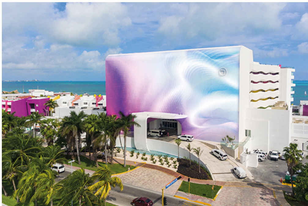
La facciata del Temptation Cancun Resort, in Messico, è decorata con elementi realizzati in bioresina dall'italiana Mosaico Digitale. Grazie a una speciale tecnica, l'immagine digitale di partenza è rielaborata, scomposta e stampata su tessere che andranno a ricomporre il disegno. Fotografia per gentile concessione di Temptation Cancun Resort
